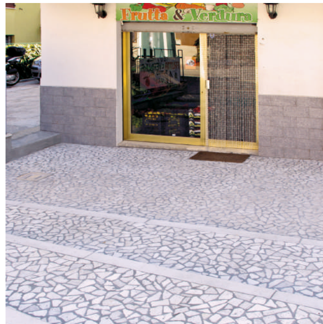
PALLADIANA BURATTATA DI TRAVERTINO
