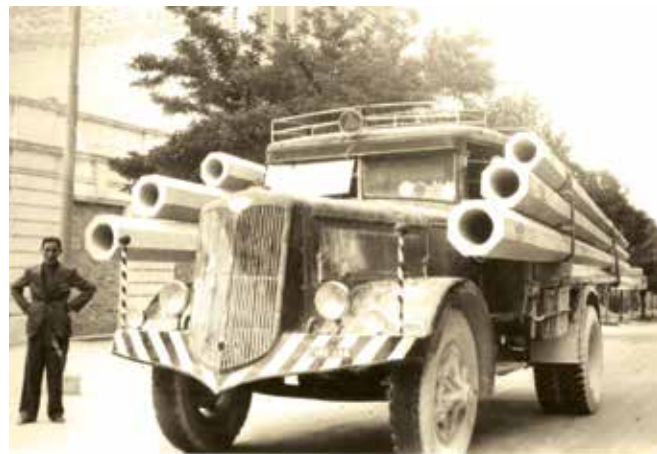
Alcune fasi del trasporto di elementi per l'arredo urbano.
